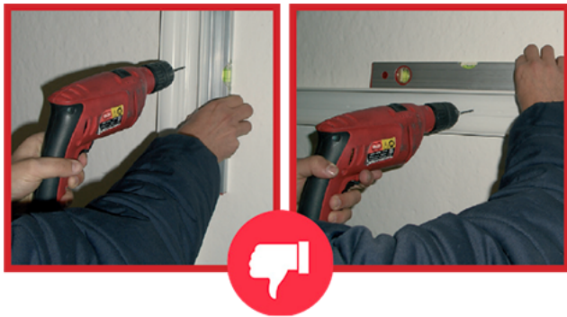
Installazione canalina senza bolla incorporata
