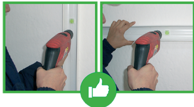
Installation goulotte avec bulle intégrée
