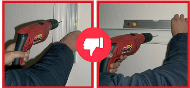
Installation goulotte sans bulle intégrée
