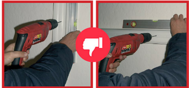
Kabelkanalinstallation ohne eingebaute Libelle
