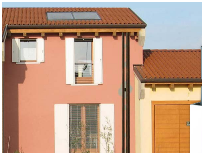
Realizzazione colonne di scarico e sfiato nuovo bagno
