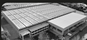
UN NUOVO PLANT PRODUTTIVO
