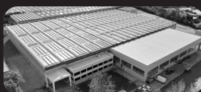
UN NUOVO PLANT PRODUTTIVO
