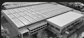
UN NUOVO PLANT PRODUTTIVO
