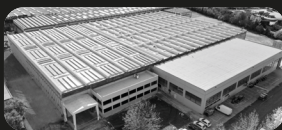
UN NUOVO PLANT PRODUTTIVO
