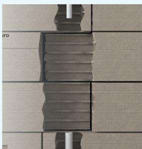
Creare la nicchia nel muro per installare sifone e tubi scarico condensa
