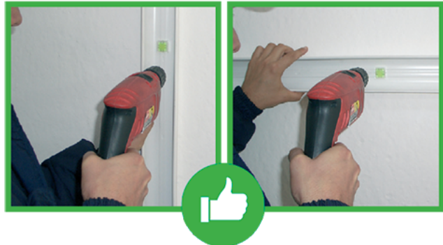
Installation goulotte avec bulle intégrée
