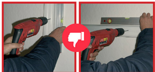
Kabelkanalinstallation ohne eingebaute Wasserwaage
