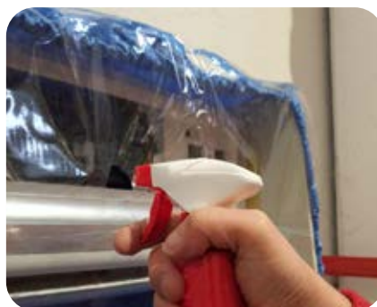
Pulizia batteria tramite foro inserimento spruzzino
