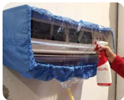
Pulizia batteria con telo di protezione applicato
