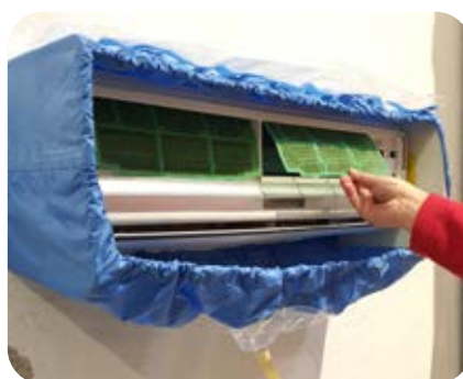
Rimozione filtri
