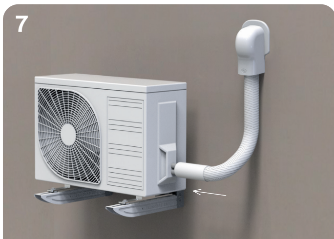
7 Cartellare le tubazioni frigorifere e fissarle ai rubinetti dell'unità esterna, collegare l'alimentazione. Avvicinare e posizionare il manicotto in gomma in prossimità dei rubinetti.
