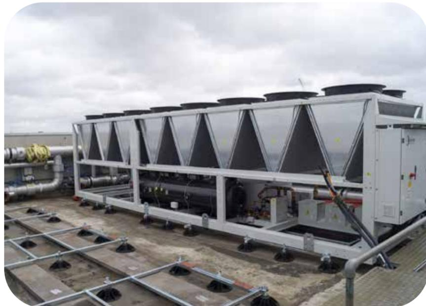
Die Struktur des Systems besteht aus hochwertigen Materialien wie verzinktem Stahl und Aluminium, die eine überlegene Widerstandsfähigkeit gegenüber Witterungseinflüssen und eine außergewöhnliche Haltbarkeit gewährleisten.
