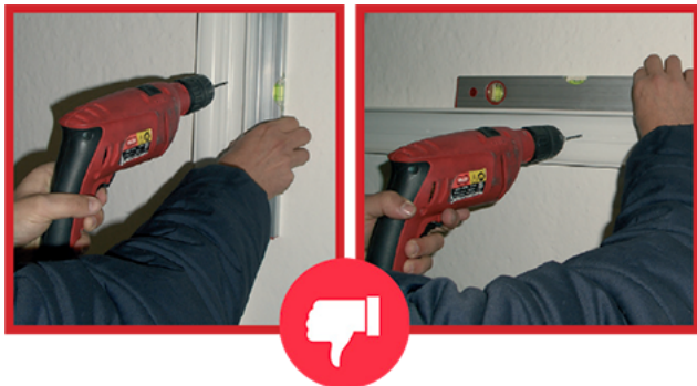
Kabelkanalinstallation ohne eingebaute Libelle
