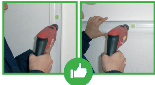
Kabelkanalinstallation mit eingebauter Libelle
