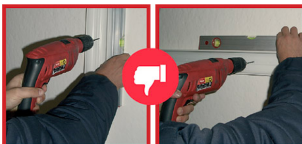
Installation goulotte sans bulle intégrée
