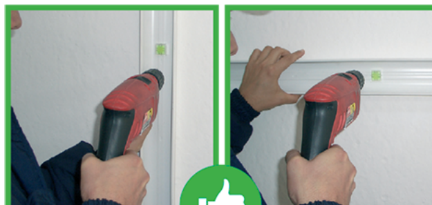
Installation goulotte avec bulle intégrée
