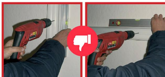
Installazione canalina senza bolla incorporata
